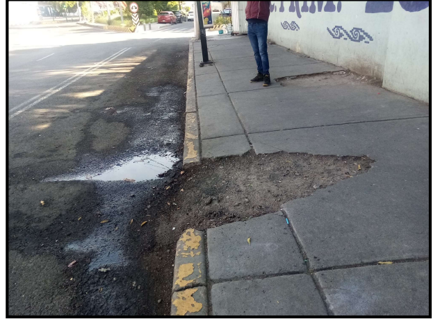
8. Mejoramiento de banqueta
