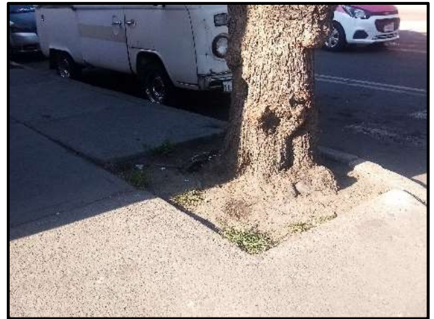
2. Mejoramiento de banqueta
